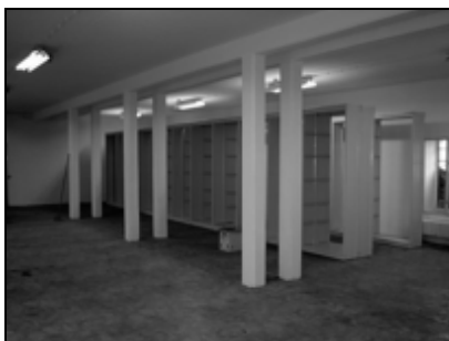
Novi depo Arhiva (objekat Margit Mlin )
