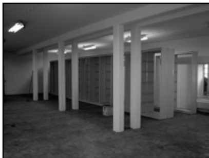
Novi depo Arhiva (objekat Margit Mlin )
