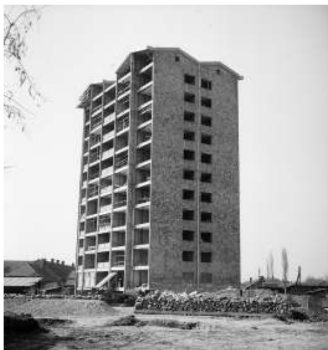
Izgradnja solitera na „Radijalcu“
