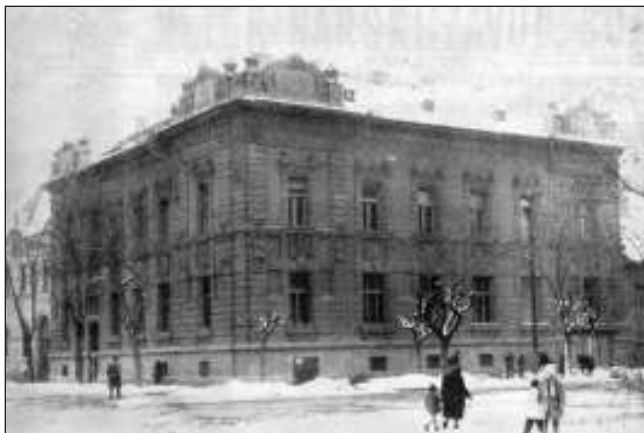
Zgrada Komunalne banke, zima 1964. godine
